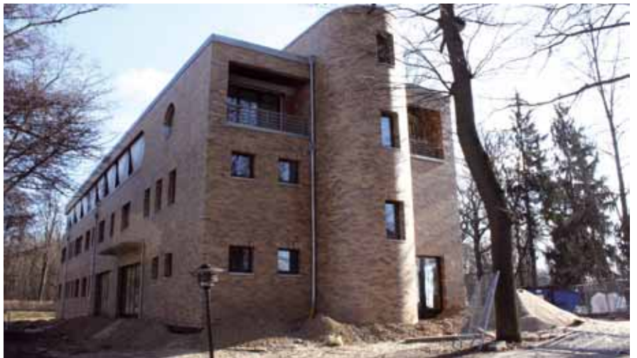
Das neue Verwaltungsgebäude geht allmählich seiner Vollendung entgegen . . .
