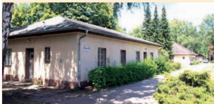
Vor dem Abriss: Drei Pavillons haben schon bald ausgedient.
